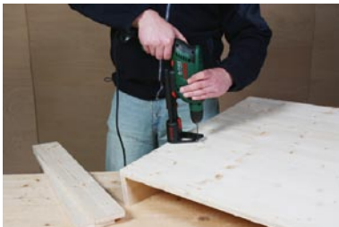
Im Abstand von 10 cm zueinander Löcher bohren
